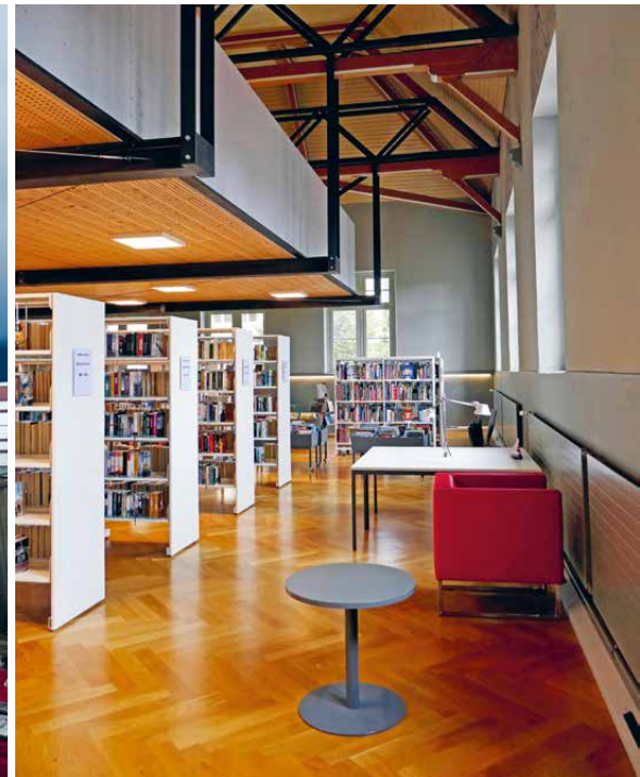
Blick vom Erdgeschoss auf die freischwebende Galerie. Diese wird von den Seitenwänden getragen, die dafür nötige Stahlkonstruktion orientiert sich am vorhandenen hölzernen Dachstuhl.
